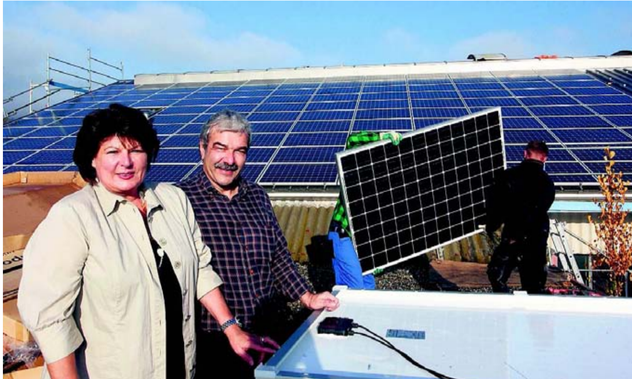
Ulrich und Marianne Lüscher während der Installation der Anlage AE
